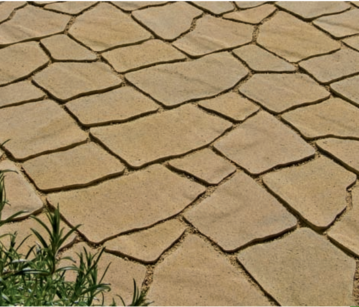
POLYGONPFLASTER NATIVO Sandstein nuanciert Fugenausbildung mit gelbem Granit-Splitt
