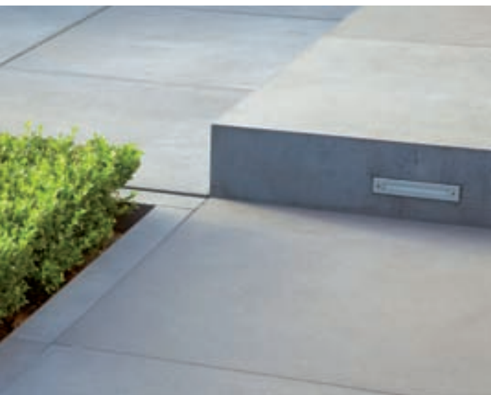
Podest Hellgrau SV-Beton mit Aussparung für Beleuchtung
