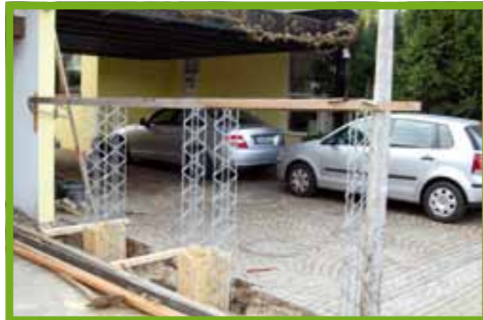
Wandsäulen ausrichten und Beton aushärten lassen.
