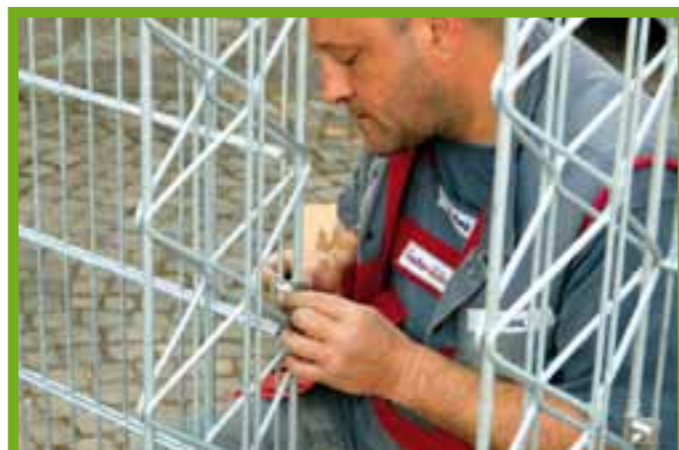
Befestigung der Rankgittermatten mittels Universalklemmen.
