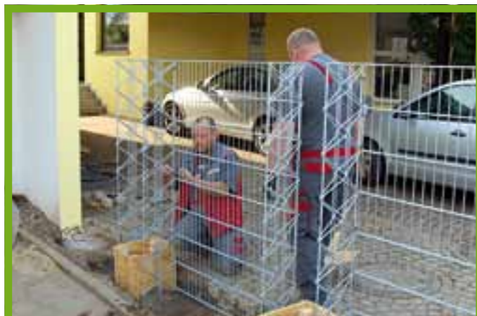
Montage der Rankgittermatten.
