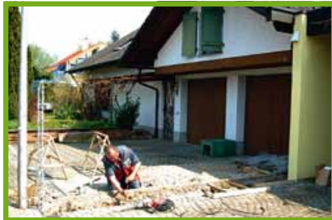
Punktfundamente einmessen und Wandsäulen flucht- und lotrecht in erdfeuchten Beton setzen.
